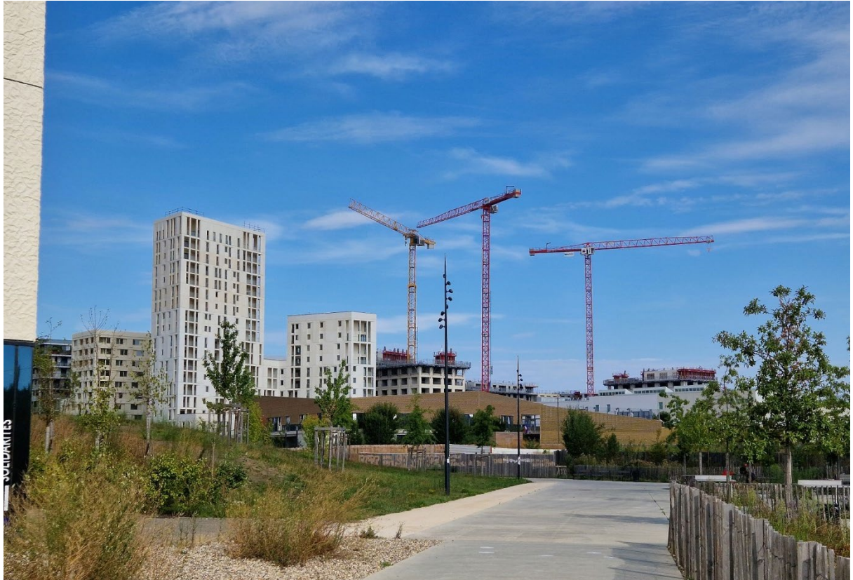
Chantiers en cours dans le quartier Euratlantique, Bordeaux. Crédit photo : K. Berrekla
